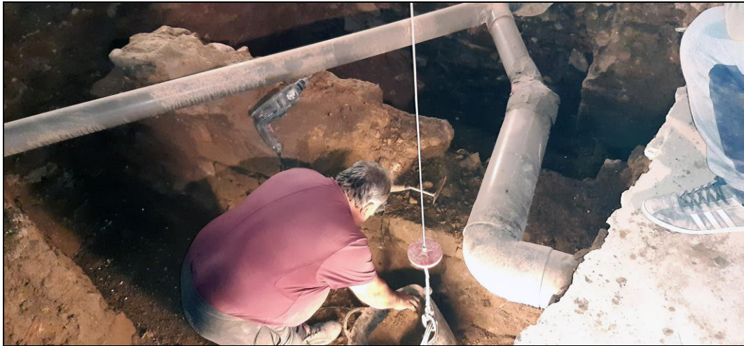
Desmuntatge manual del mur UE 106
