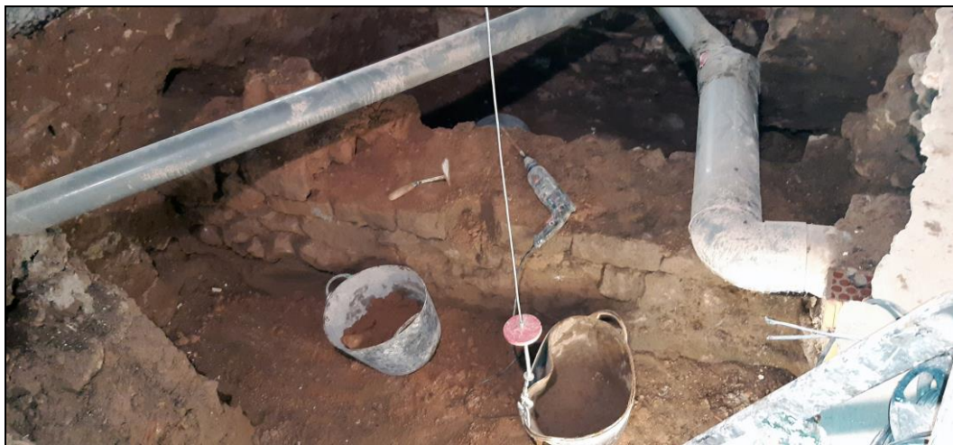
Desmuntatge manual del mur UE 106
