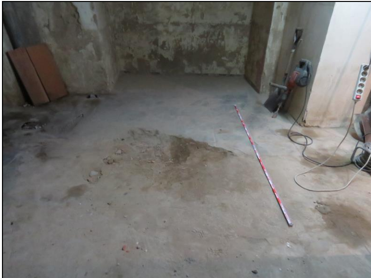
Vista de l'espai destinat a fer la instal·lació dels ascensors
