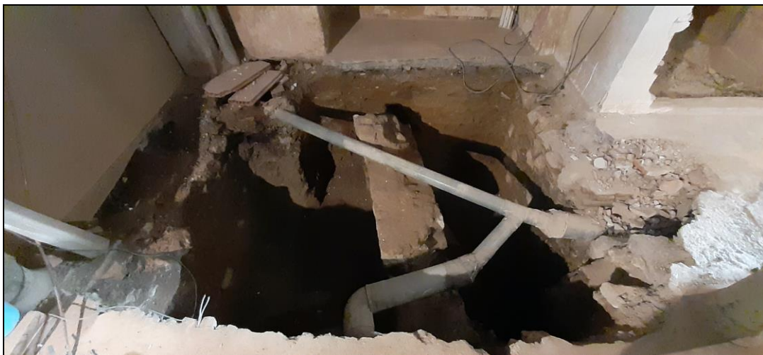
Vista de la instal·lació provisionals dels tubs de PVC
